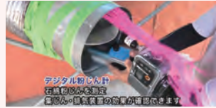
石綿粉じんの測定
