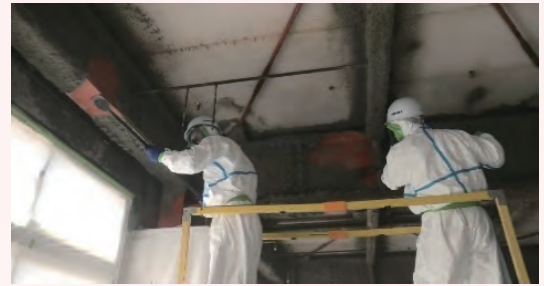
吹付け石綿の除去
