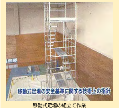
移動式足場の組立て作業
