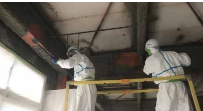
吹付け石綿の除去
