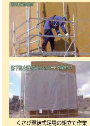
くさび緊結式足場の組立て作業
