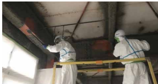
吹付け石綿の除去
