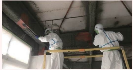
吹付け石綿の除去
