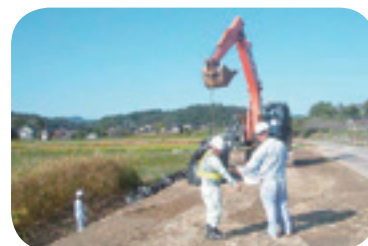
地震災害復旧工事現場
