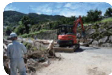
大規模地滑り災害復旧工事現場
